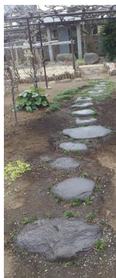
踏み石の段差をなくして、安全に散策ができるように整備。
