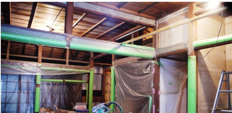
臨春亭内部の耐震補強工事は、壁を耐震壁に張り替えるのが主なもの
